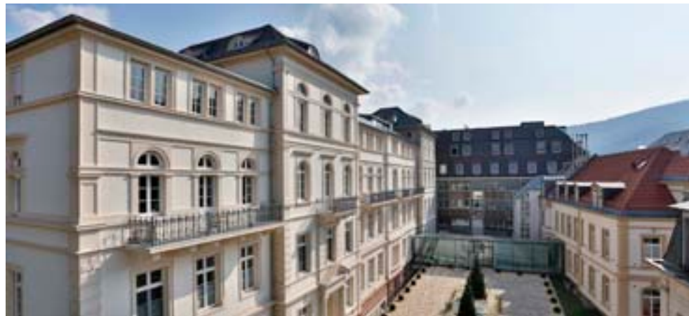
Das ATOS Carré: Links das größere der beiden Gebäude der ehemaligen Kinderheilanstalt. Es wird heute noch von vielen Mitarbeitern die „Große Luise“ genannt (Gebäude C), ihr gegenüber rechts die sog. „Kleine Luise“ (Gebäude B), dazwischen das Hauptgebäude A.
